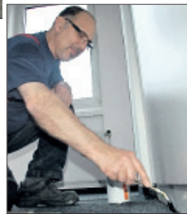
In dieser Woche beziehen die Pralle-Mitarbeiter den neuen Firmensitz am Frankenring. Werner Hummel, Mitarbeiter der Firma Mero TSK, bereitet das Einkleben der Kettelleiste für den Teppich vor. Flinkert (2)
